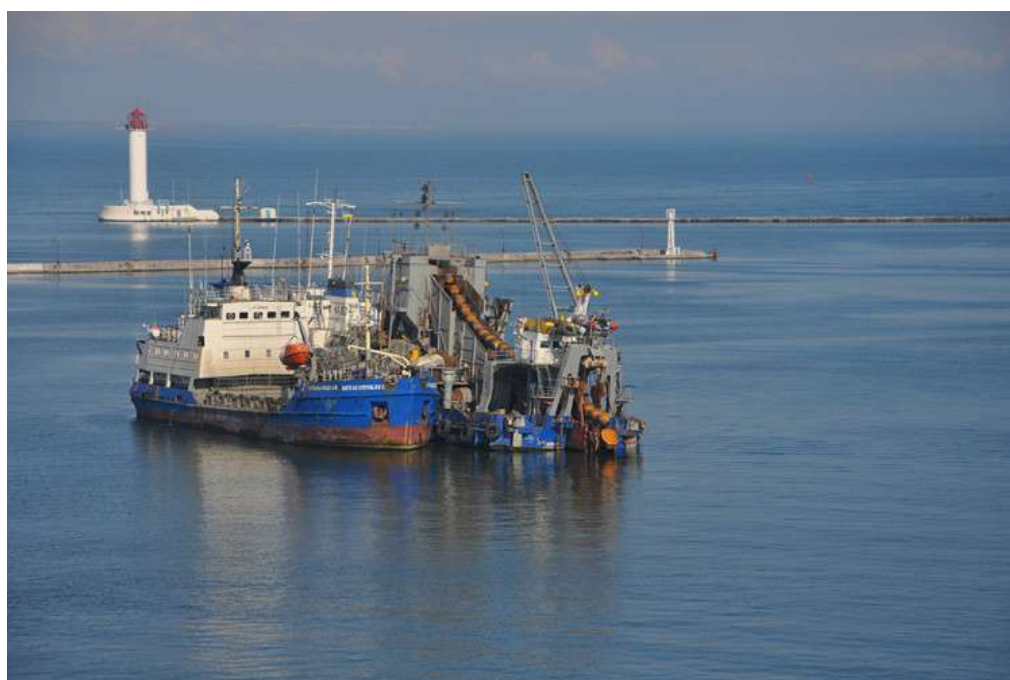
Рисунок 4.2 – Проведення днопоглиблювальних робіт в акваторії Одеського порту
