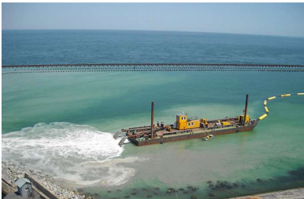
Рисунок 4.1 – Проведення днопоглиблювальних робіт (річка Дунай)
